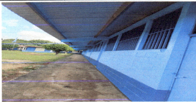
Foto 1: Se observa la colocación de los balcones de metal para mejorar la ventilación e iluminación dentro del aula.
