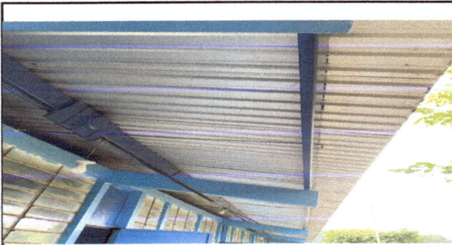
Foto 3: Se observa las costaneras dándoles un aspecto nuevo y así mejorar el ambiente dentro del aula
