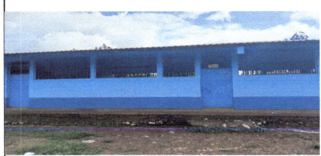
Foto 2: Aplicación de pinturas en las paredes interiores y exteriores del establecimiento
